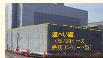
緊急時対応要員を被ばくから守るための免震重要棟の遮へい壁の設置
