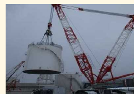
飛来物の衝突に耐えうるよう鋼板が厚い軽油タンクへ取替
