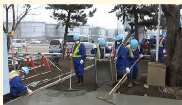
汚染状態に応じた装備区分の変更（構内専用服での作業）
