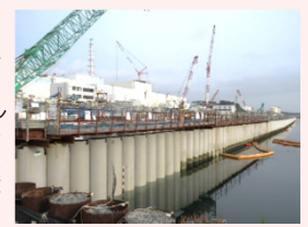
海側遮水壁 鋼管矢板打設完了状況
