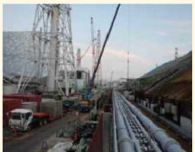
2～4号機西側に敷設した凍結管
