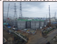
H1東エリア解体開始時の様子
