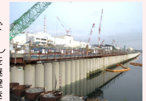
海側遮水壁 鋼管矢板打設完了状況
