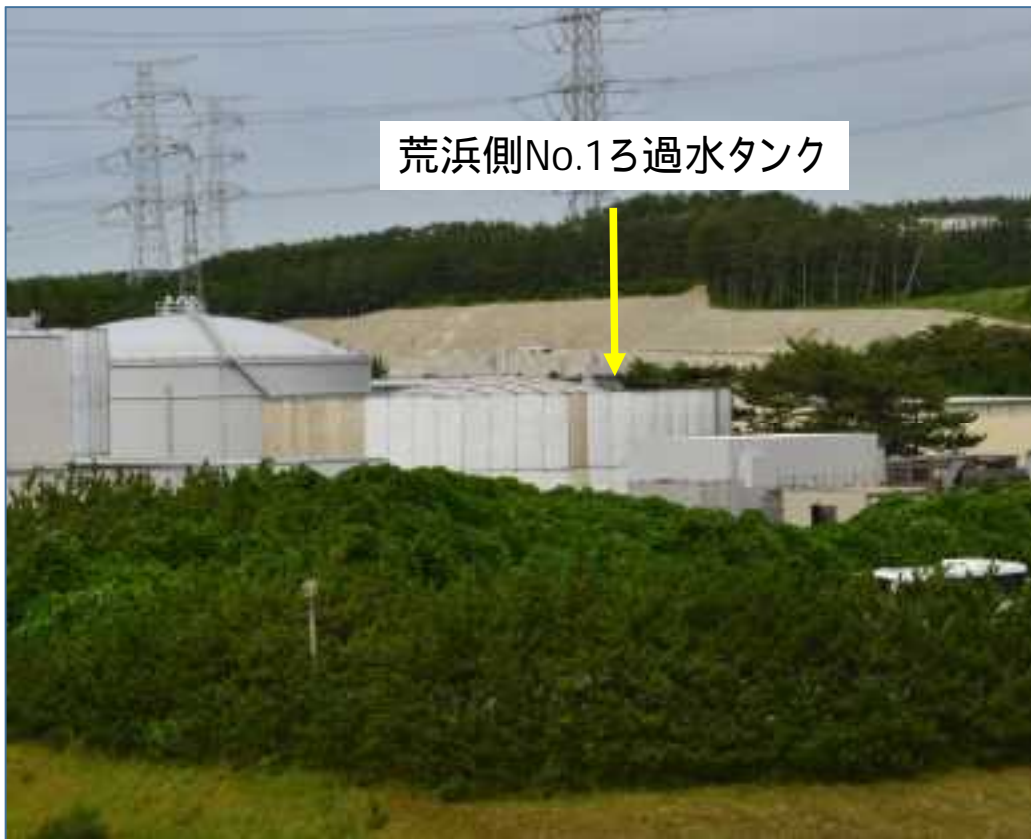
ろ過水タンク全景
