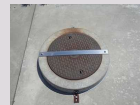
マンホールの固定【6,7号機】
