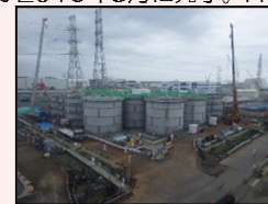
H1東エリア解体開始時の様子
