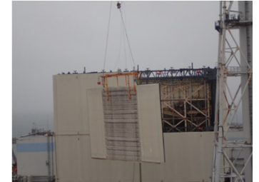
(1号機建屋カバー壁パネル取外状況)
