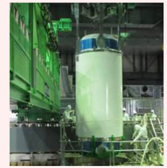
燃料取り出し状況
