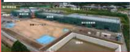
現地工事進捗状況(平成28年9月27日)
