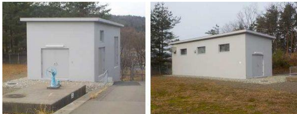
建屋の外観(出典:柏崎ガス水道局)
