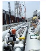
(凍結管バルブ開閉操作の様子)
