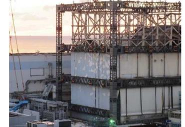
(1号機建屋カバー壁パネル取外状況)
