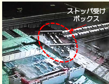
＜ストップ設置作業の状況＞ ※：燃料取り出し用カバーを原子炉建屋に水平支持させる突起状部材
