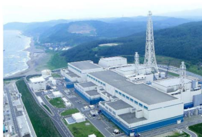
柏崎刈羽原子力発電所
