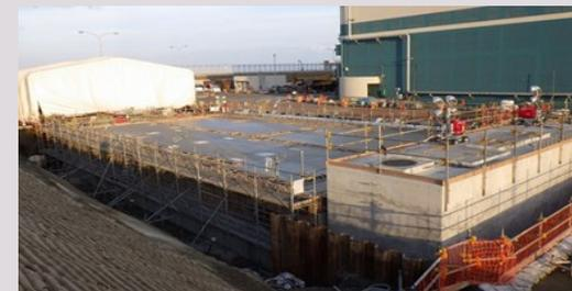
7号機 タービン建屋脇の基礎工事（コンクリート打設後）
