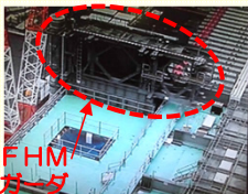
<FHMガーダ設置状況>
