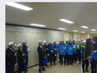
5号機 緊急時対策所設置予定エリア (原子力規制委員会による現地調査)
