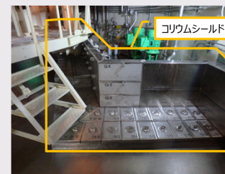
6号機 コリウムシールドの設置
