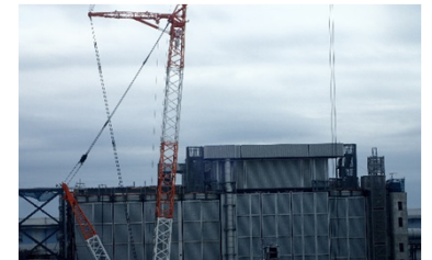
3号機燃料取り出し用カバー設置状況 (2017/6/27)
