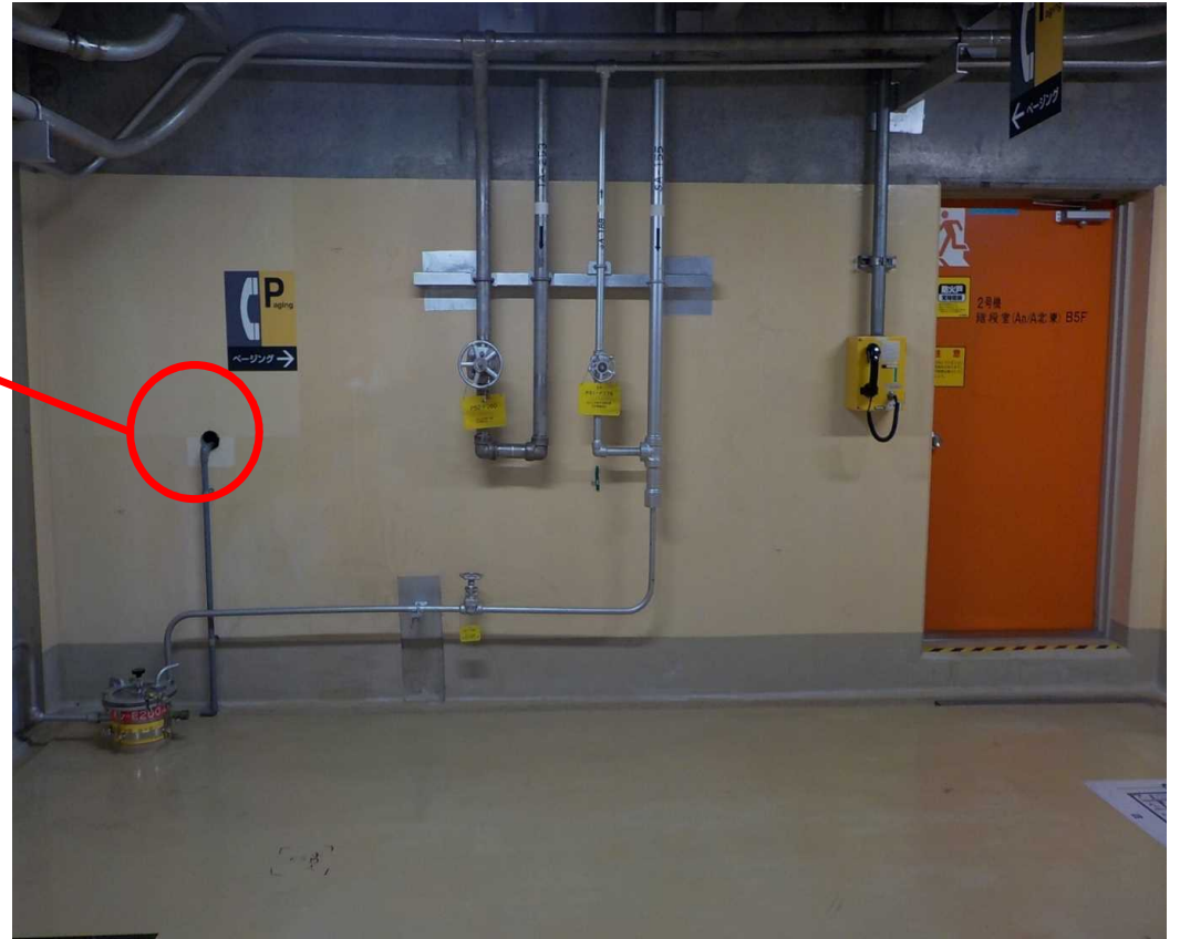
地下5階北東廊下側
