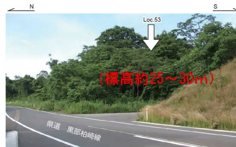
Loc. 53の現況写真①（2017.7撮影）
