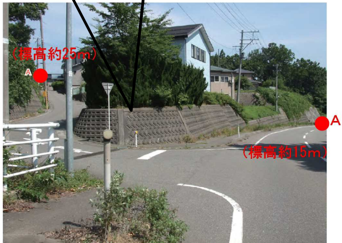
Loc. 54の現況写真 (2017.7撮影)
