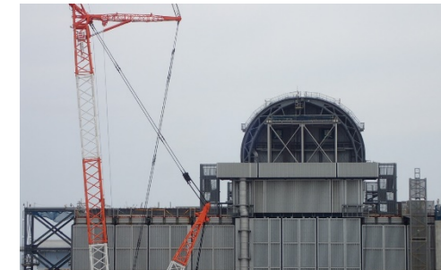
3号機燃料取り出し用カバー設置状況 (2017/8/28)
