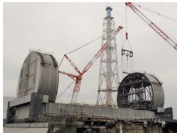
3号機 燃料取り出し用カバー（ドーム屋根）設置作業（9月6日）
