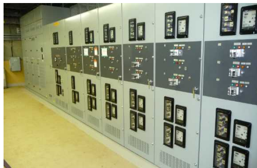
1号機 電源盤(P/C 1G-1)据付後
