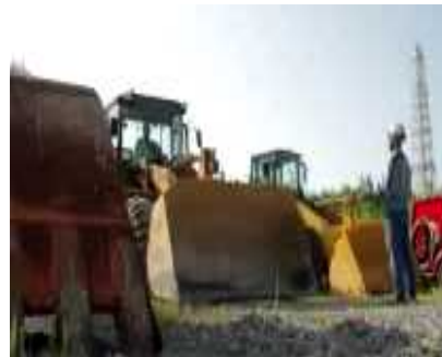
ガレキ撤去訓練
