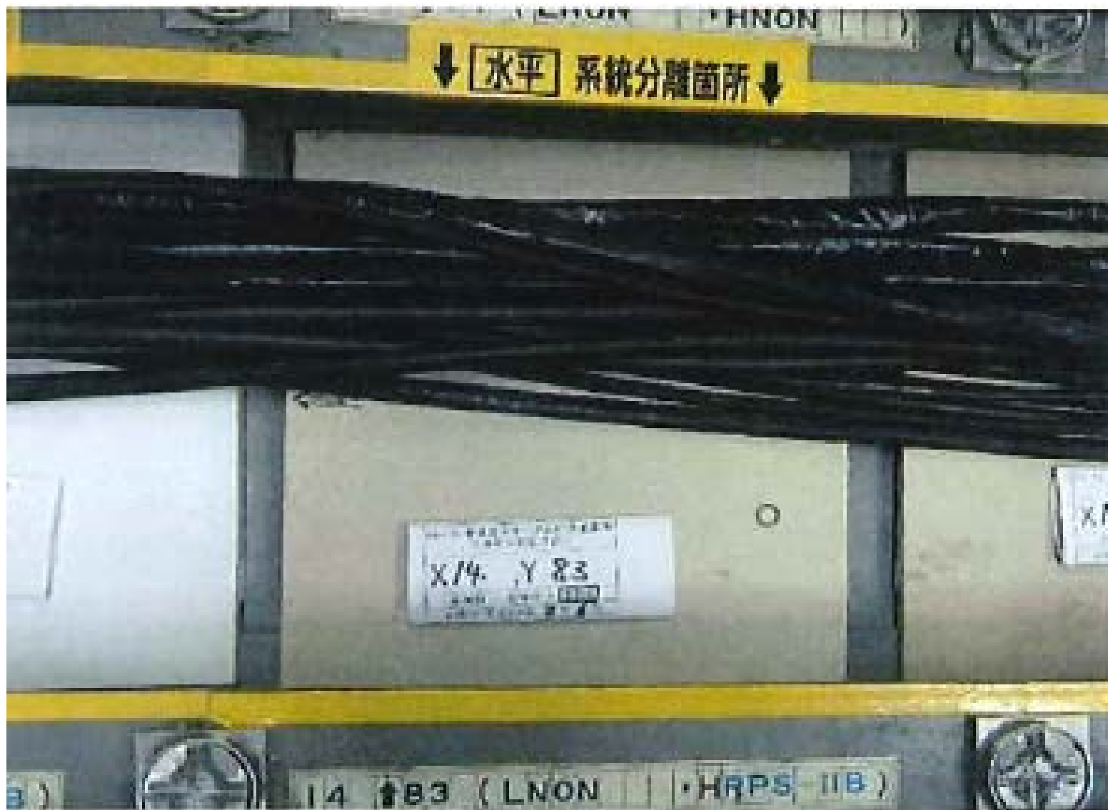
総点検後の状況(2017年2月6日撮影)
