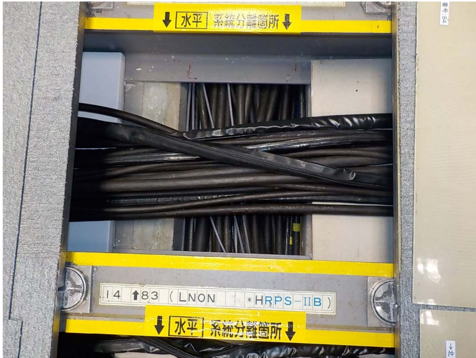
本日作業前の状況(2017年10月26日撮影)
