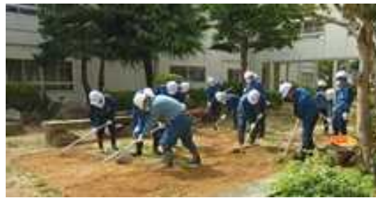
除染作業の様子
