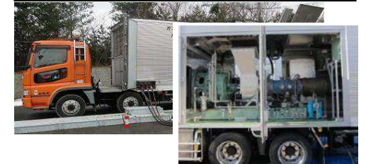
ガスタービン発電機車 (高台配備)
