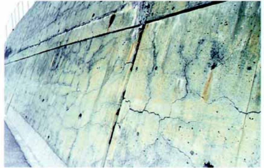
アルカリ骨材反応によるひび割れの例
