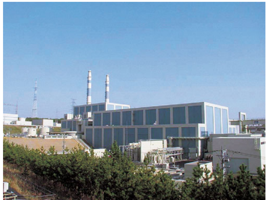
志賀原子力発電所
