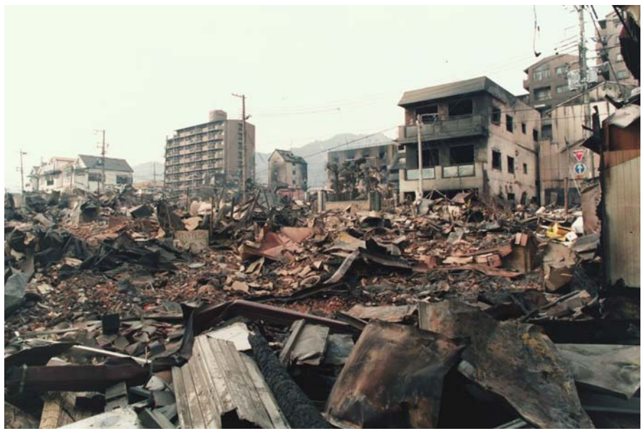
神戸市内の被害の様子
