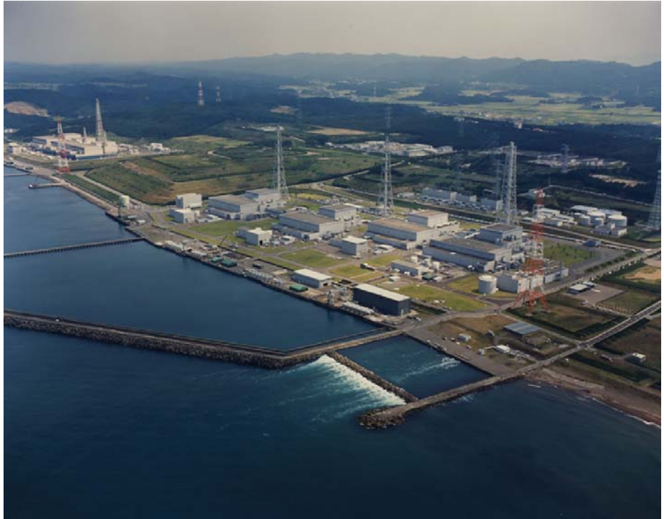
柏崎刈羽原子力発電所
