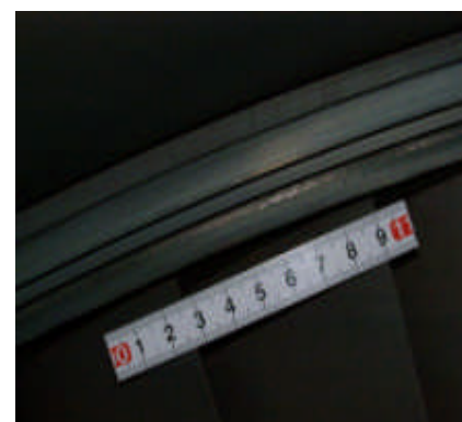
第9段発電機側ダイヤフラム
