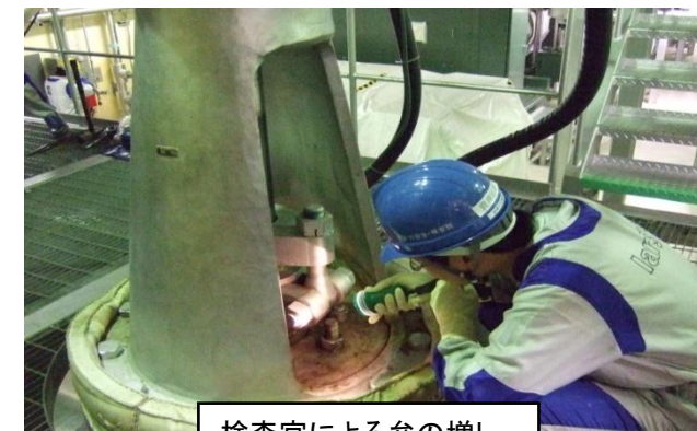
検査官による弁の増し締め状況の確認
