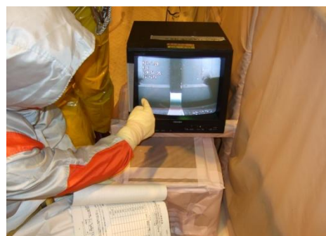
水中カメラによる結合状況の確認
