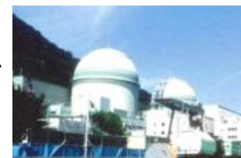
135万kWの原子力発電所
