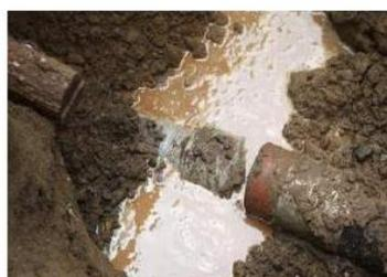
埋設された消火系配管の破損
