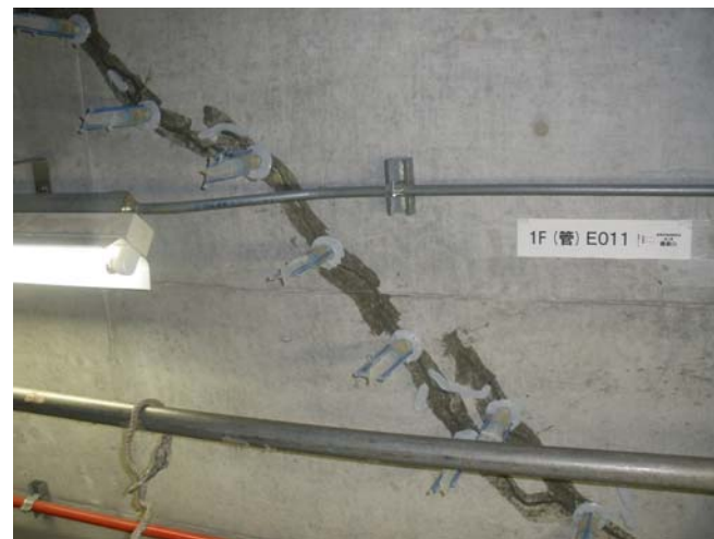
エポキシ樹脂注入
