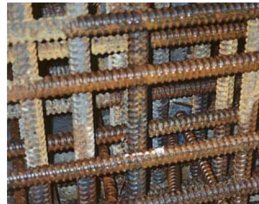
7号機原子炉建屋の配筋例
