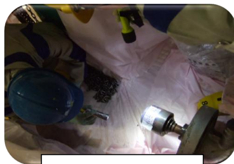
弁の分解点検の確認状況
