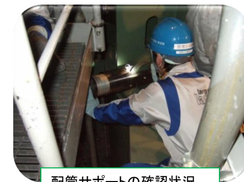
配管サポートの確認状況
