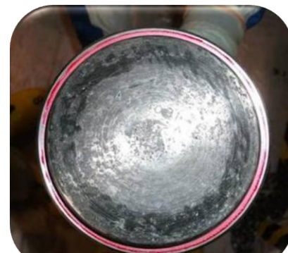
弁の復旧状況を確認(全体的にきちんとあっている。)
