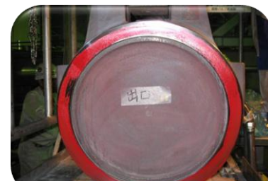
弁の復旧状況を確認(全体的にきちんとあっている。)
