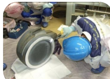
弁の分解点検の確認状況
