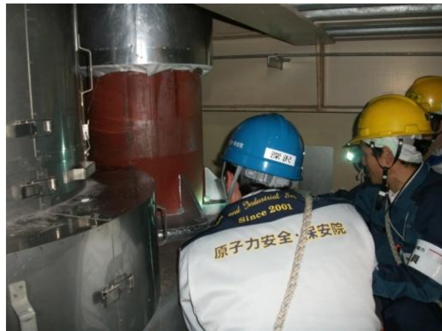
残留熱除去系配管支持構造物の確認
