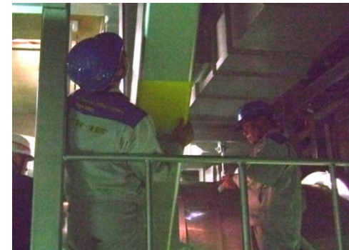
原子炉補機冷却海水系配管の確認
