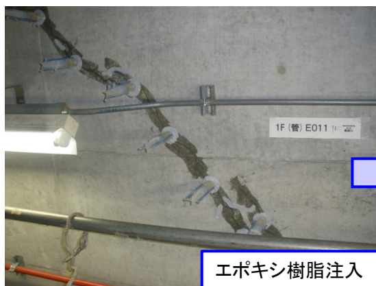
ひび割れの補修状況(右平面図のE011側から見た状況)
