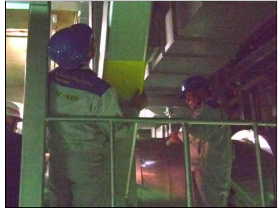
原子炉補機冷却海水系配管の確認
