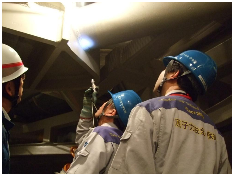
原子炉格納容器スタビライザの確認
