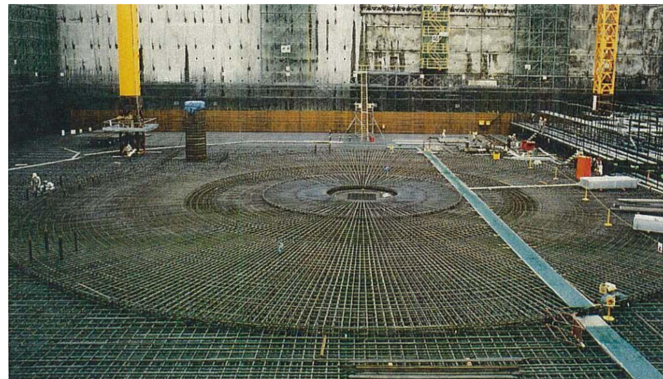
5号機原子炉建屋 基礎スラブの配筋状況
