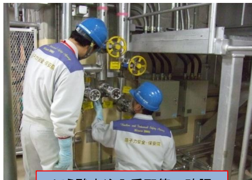
ほう酸水注入系配管の確認
