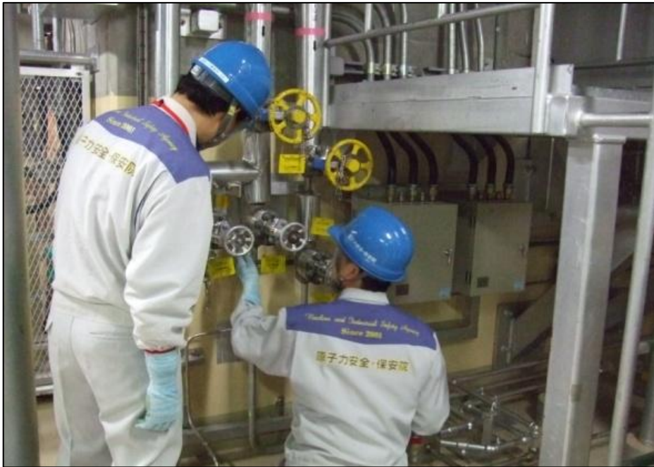
ほう酸水注入系配管の確認
