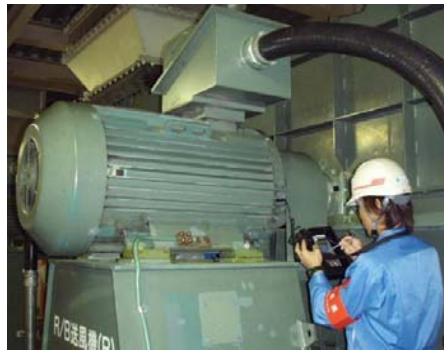
協力企業の有資格者による設備診断（実際のデータ採取の様子）
