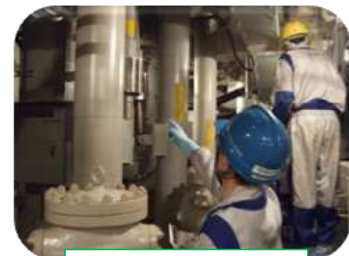
配管サポートの確認状況
