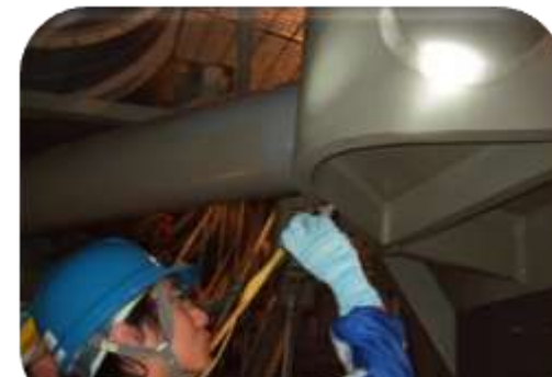
原子炉格納容器スタビライザの確認状況
