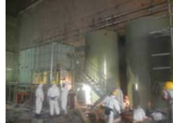
除染装置据付
