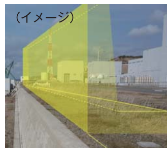
1～4号機側の防潮堤（堤防）
