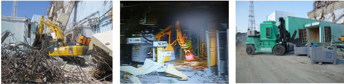
無線バックホウによる外部柱撤去
