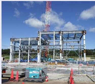
<建設状況（2021年10月20日撮影）>
