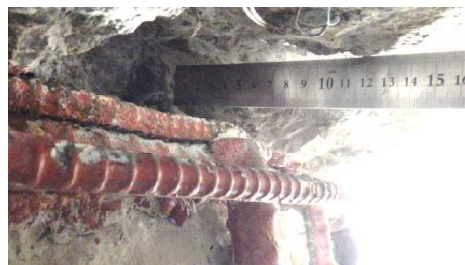
②番：主筋破断部
