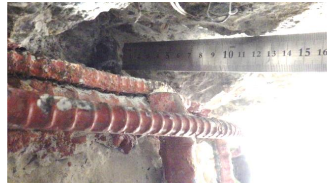
②番：主筋破断部
