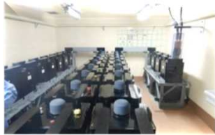
所内蓄電式直流電源設備
