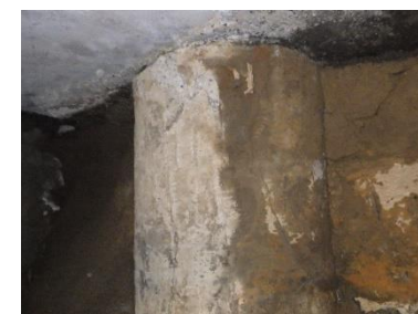
No.8 杭 調査前
