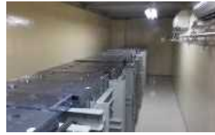
所内蓄電式直流電源設備
