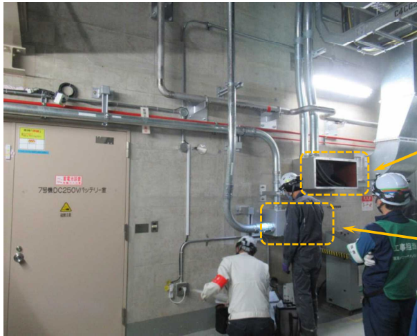
貫通部総点検の様子
