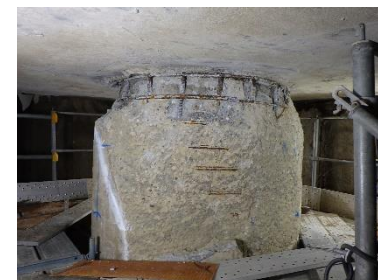
No.8 杭 コンクリートはつり後
