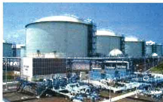
<福島基地（長崎県）（LPガス）>
