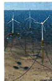
＜浮体式洋上風力の例＞
