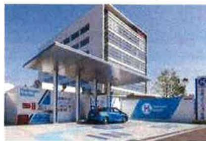
<中規模水素ステーション>
