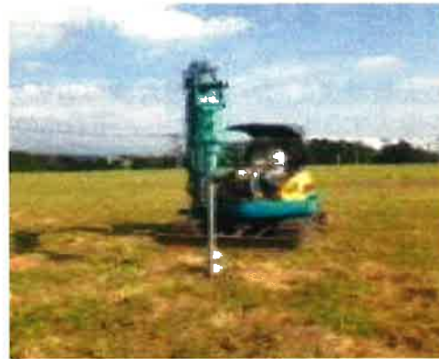
（設備設置のための調査）
