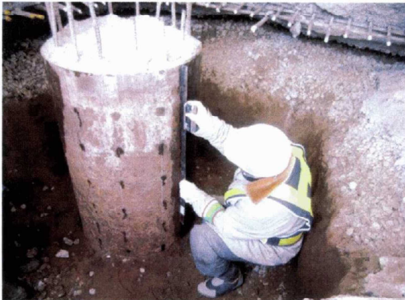
杭確認時の様子
