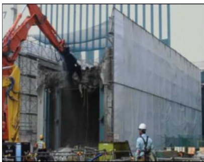
上物解体状況
