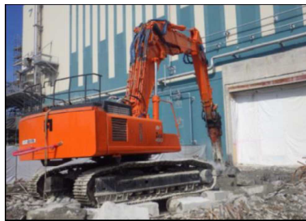
基礎解体状況
