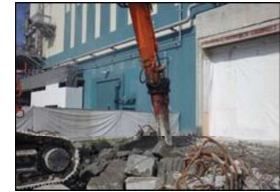
基礎解体状況
