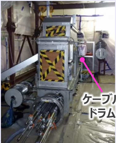
<装置の設置状況>
