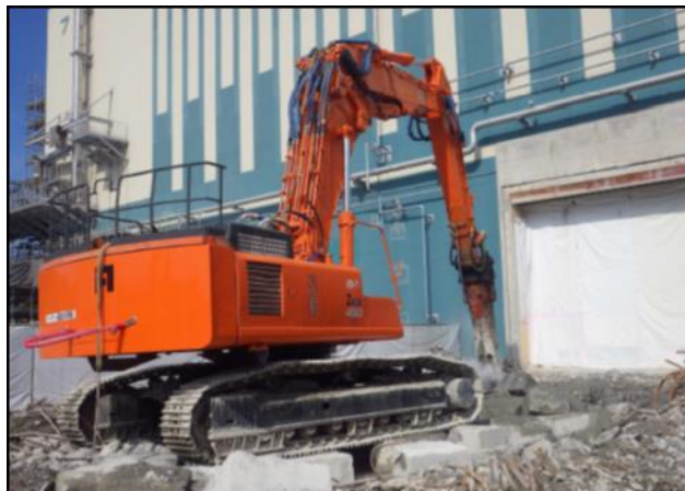
基礎解体状況
