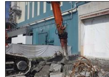
基礎解体状況
