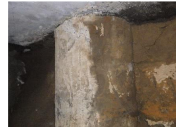
No.8杭 調査前
