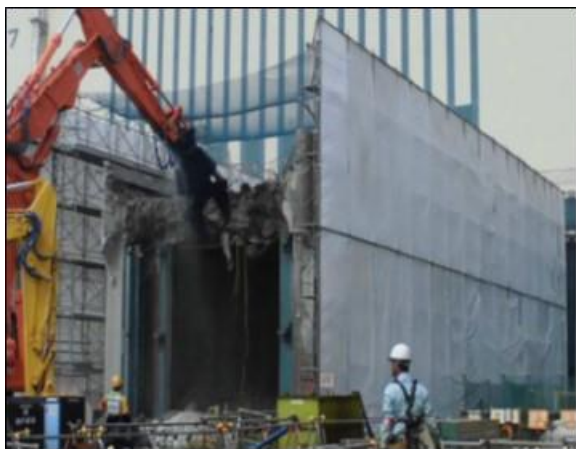
上物解体状況
