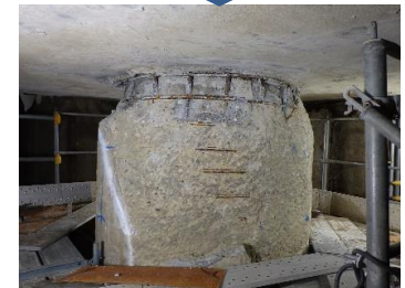
No.8杭 コンクリート はつり取り後
