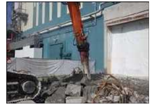
基礎解体状況
