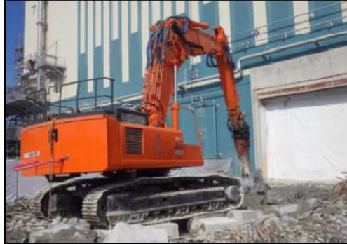
基礎解体状況
