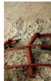
No.8杭主筋の破断状況
