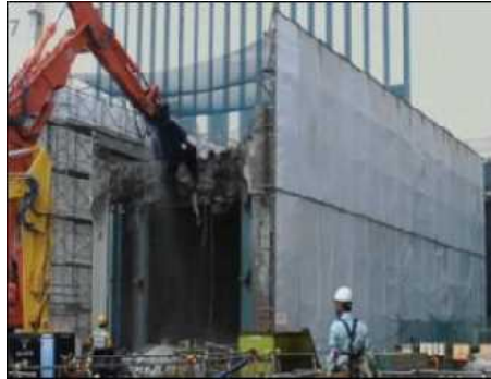
上物解体状況
