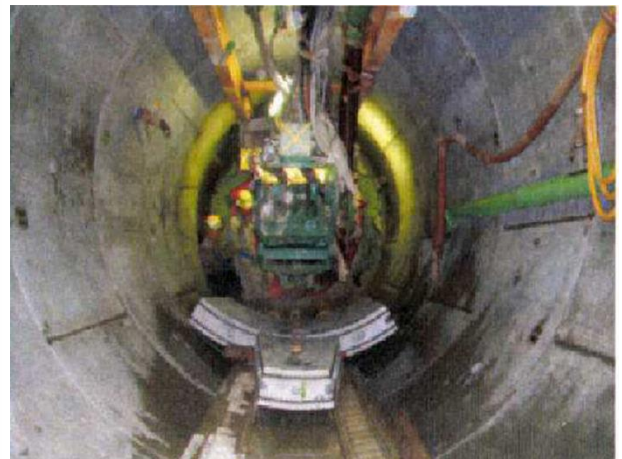
新設洞道掘削時のシールドおよび施工写真
