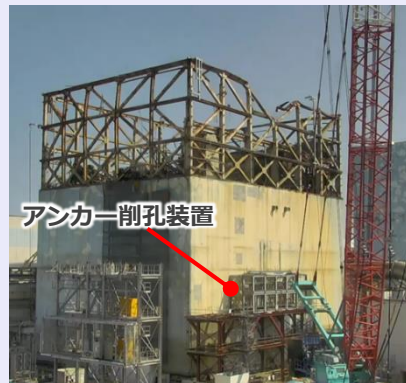
<現場状況（北西より）> (撮影：2022年4月12日)
