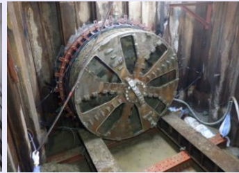
<①上流側推進管内部の状況> <②上流側推進管到達状況>
