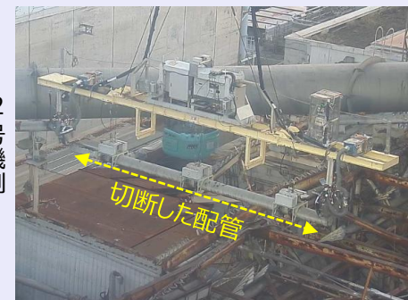
<配管切断作業の様子>
