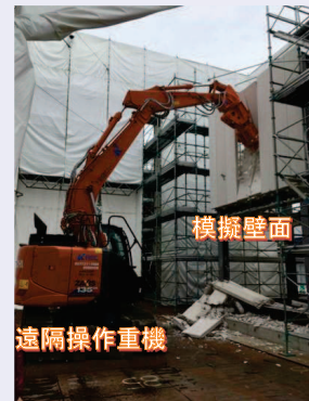
<燃料取扱機操作室撤去モックアップの様子>
