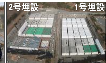
1号、2号埋設施設
