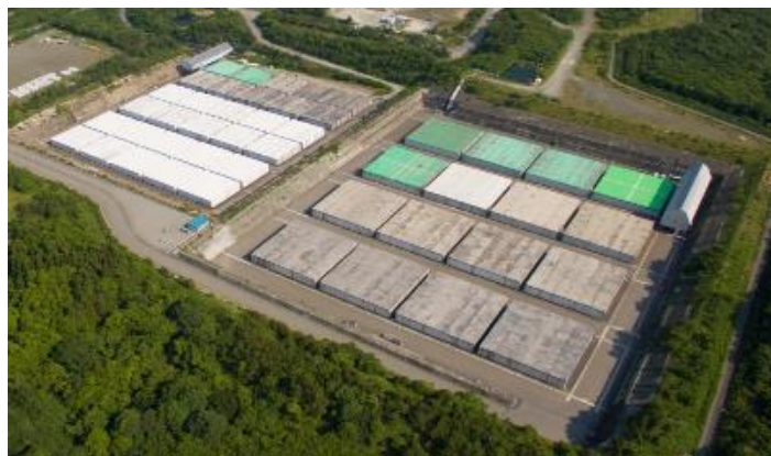
埋設センター外観
