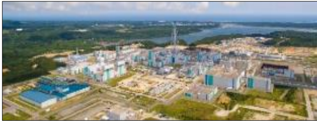
再処理施設 全景
