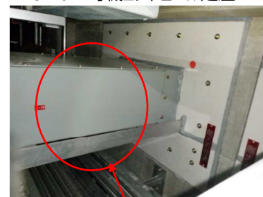
e. 6・7号機コントロール建屋
