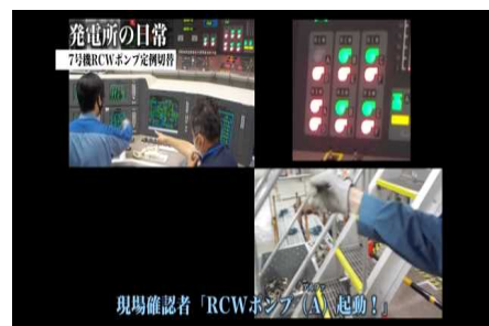
『原子炉補機冷却系ポンプ定例切替』
