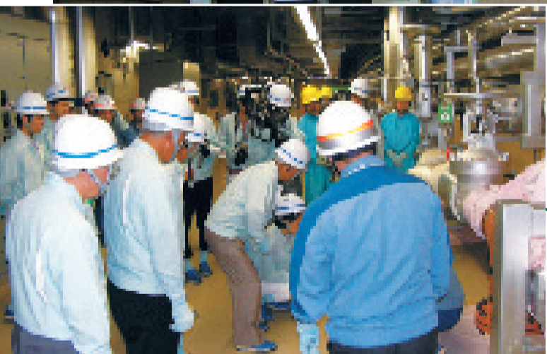
▲配管検査状況視察(平成16年9月12日・13日) 美浜3号機事故を受けて実施した柏崎刈羽4号機視察
