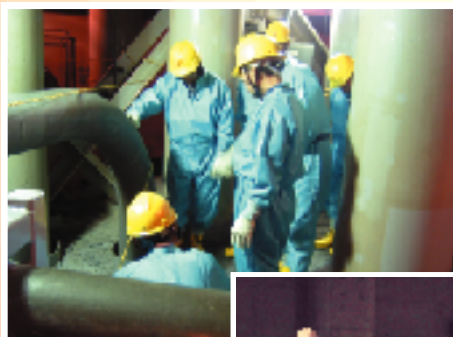
圧力抑制プール上部
