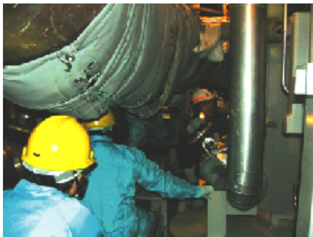
再循環系配管の補修箇所を確認
