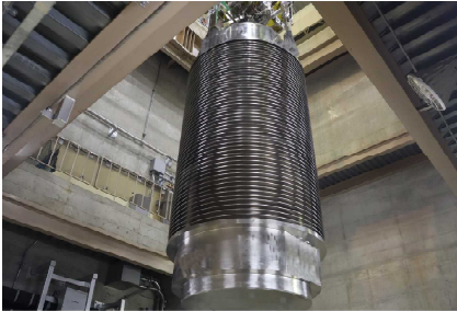
③ 原子炉建屋最上階から輸送車両へ吊り降ろし
