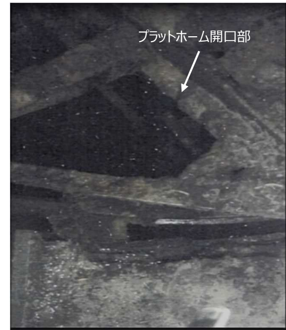
テレスコ式アームカメラの画像 (ペDESTAL開口部、プラットフォーム開口部の状況)
