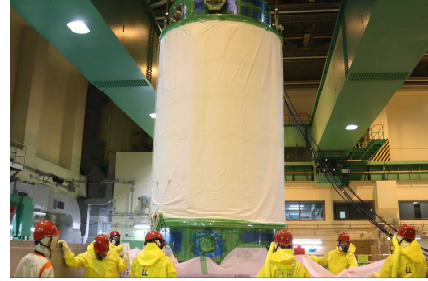
② キャスクを使用済燃料プールから吊り上げ
