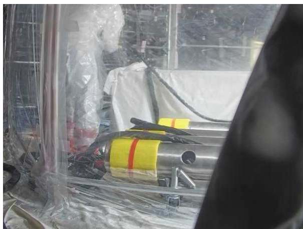
押し込みパイプケーブル入線作業を実施 (2024年7月28日)
