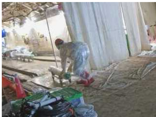
原子炉建屋内1階大物搬入口から 西側通路へ運搬 (2024年7月27日)
