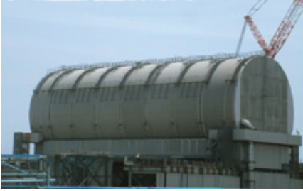
3号機建屋 ドーム屋根が設置されている
