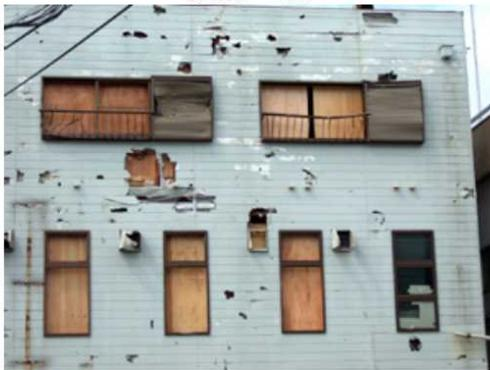
飛散物による家屋への被害（平成18年9月17日：宮崎県延岡市）
