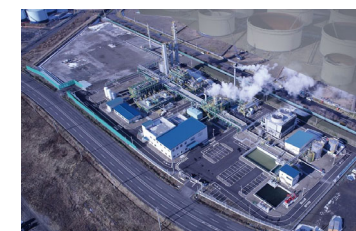
CO2分離・回収・貯留施設
